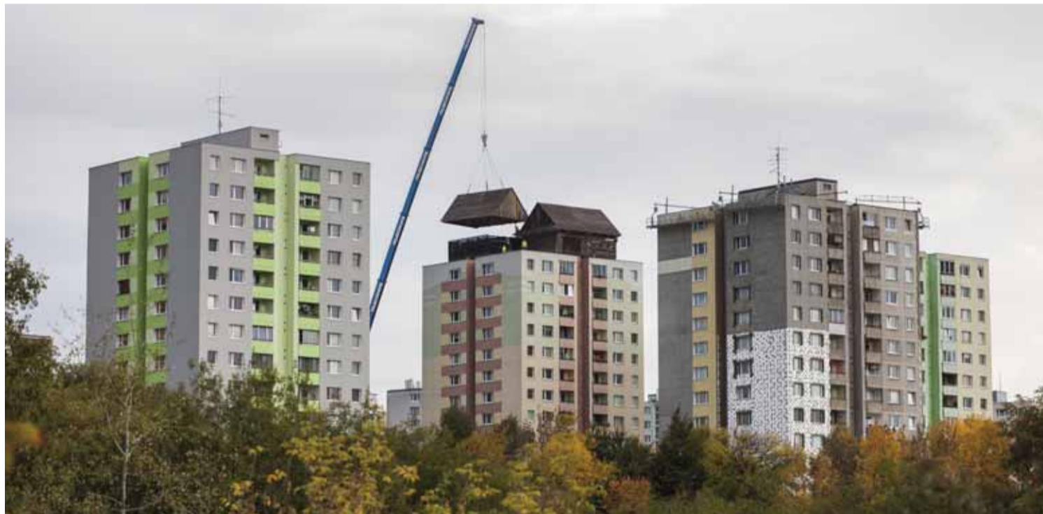
Instalace dřevěných stodol na střeše paneláku v Košicích. Foto Vlado Eliáš
