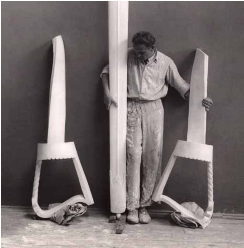
Dokumentace k pomníku Jana Žižky na Vítkově (postup prací)
