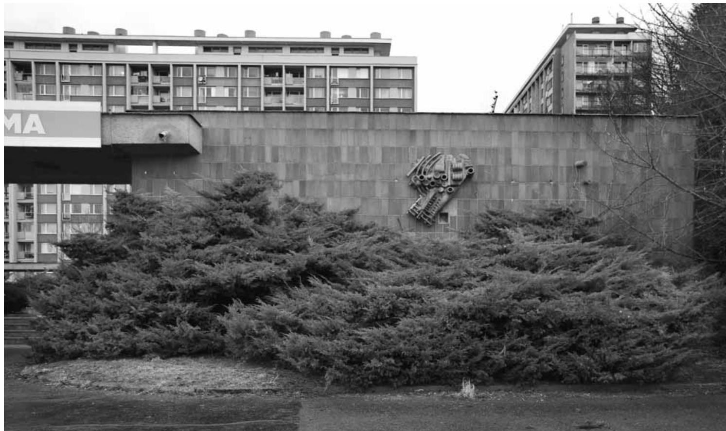
Skupina Ládví: Prostřihání keřů, znovuoobnovení pohledu na kovový ozdobný reliéf, Ládví, sídliště Ďáblice, říjen 2005
