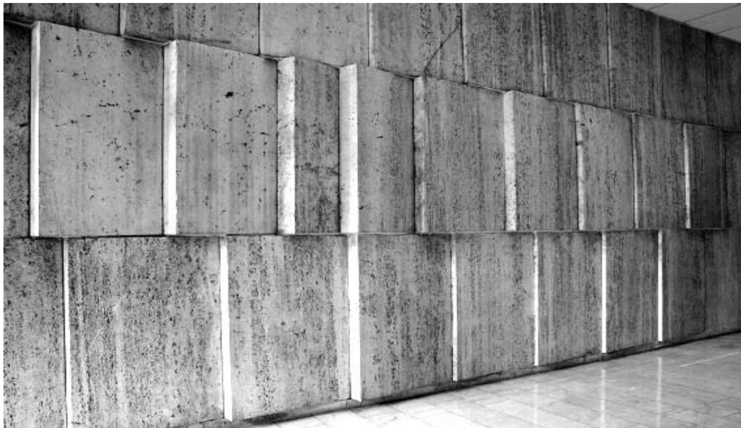
Zdeněk Šimek: Stěna vstupního vestibulu objektu bývalého Federálního shromáždění, Praha – Nové Město, 1969–1970. Foto Václava Uhlíkové
