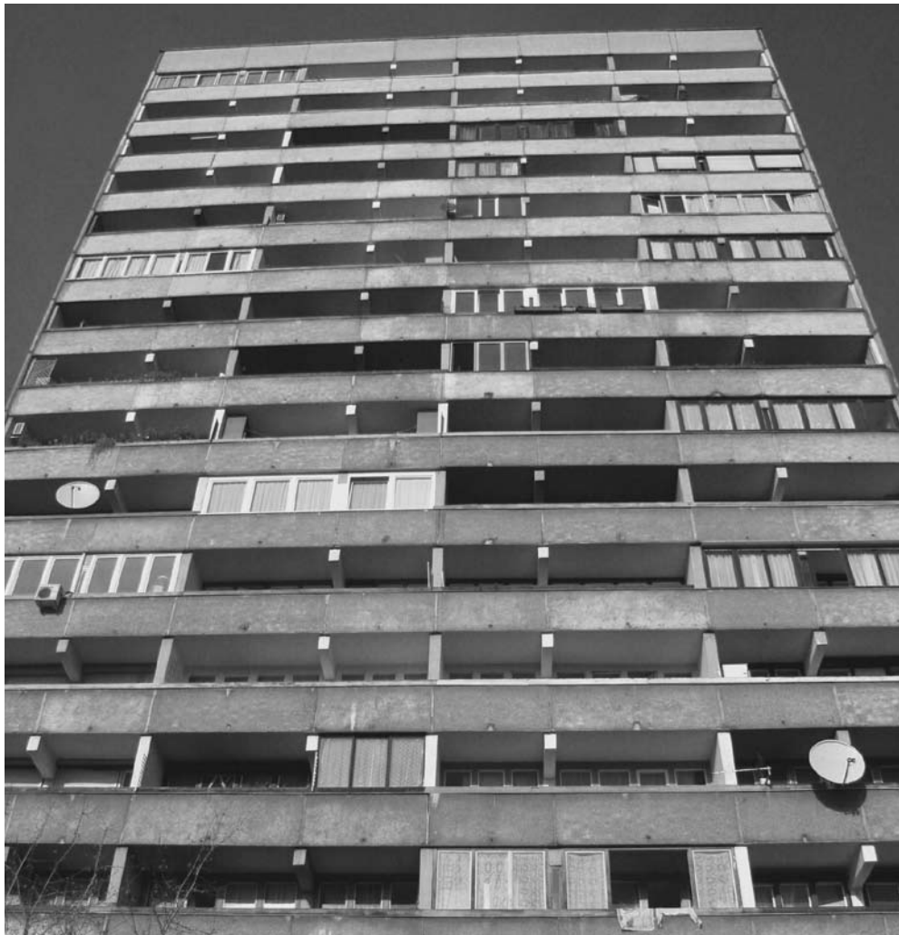
Panelové domy na sídlištích však pro někoho, možná překvapivě, mohou mít i dnes řadu výhod.
