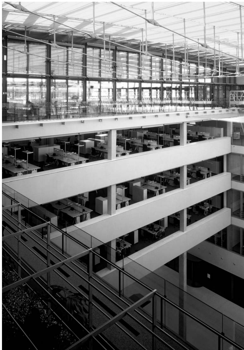
Jedna z největších investic svého druhu u nás: Josef Pleskot – ústředí banky ČSOB v Praze-Radlicích, projekt 2003, realizace 2007. Foto Jan Malý
