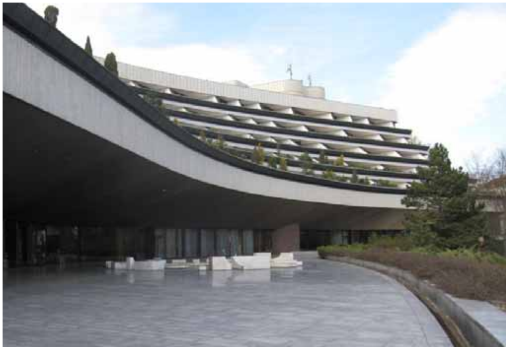
Jižní fasáda s „tekutými“ terasami kopíruje vrstevnice svahu. Foto Pavel Karous
