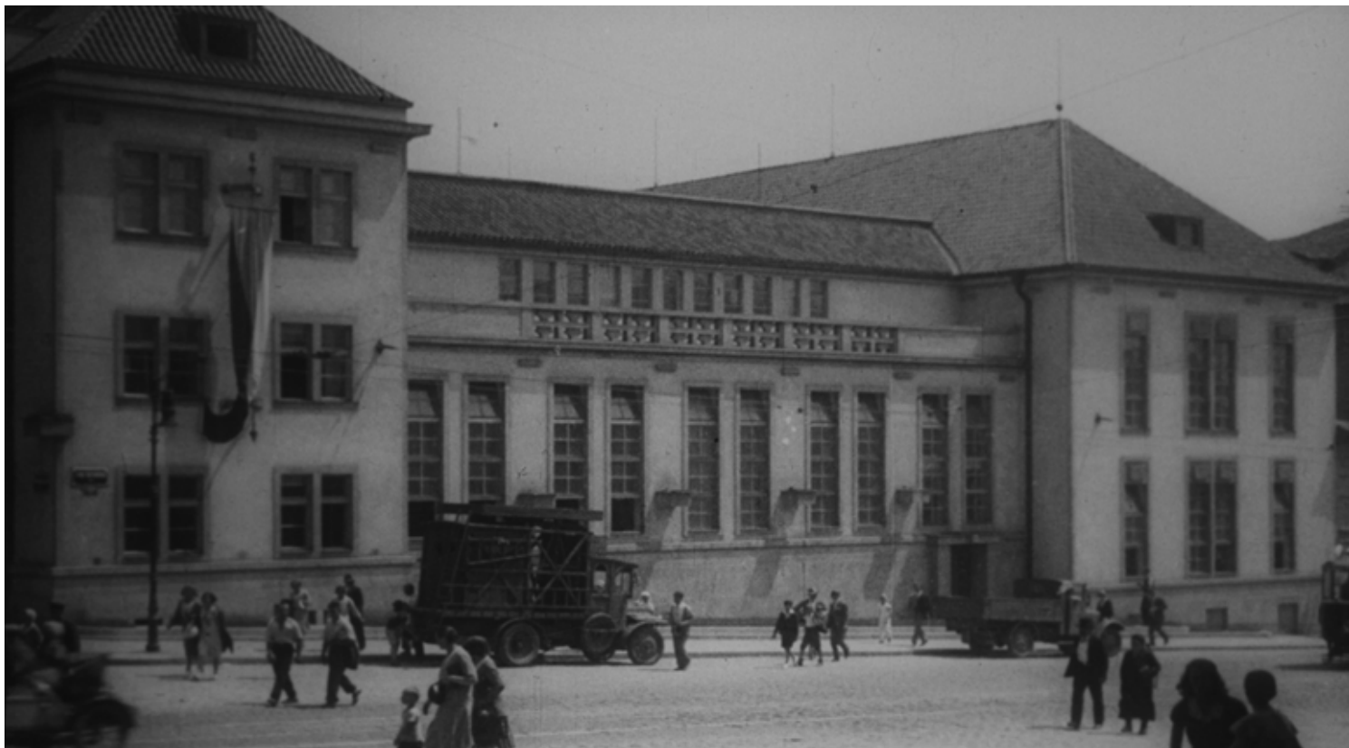
Zengerova transformační stanice na Malé Straně. Foto Kunsthalle Praha
