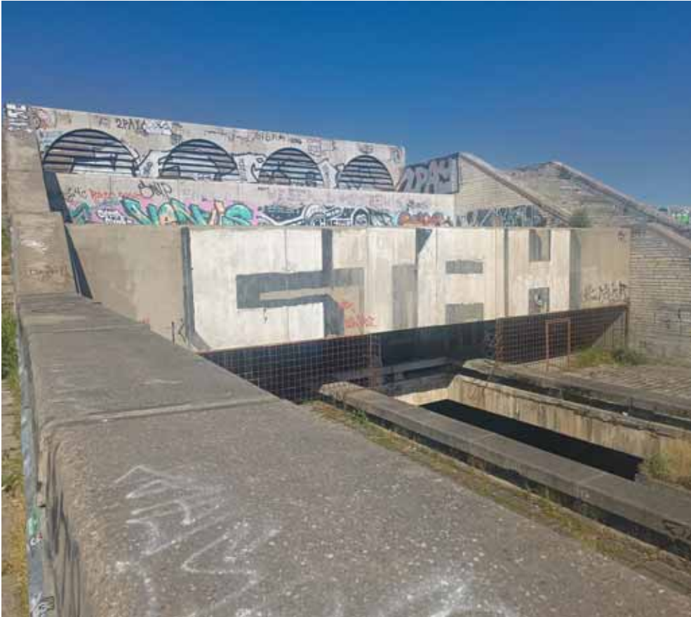
V Tallinnu vystřídal dřevěné domky monumentální sportovní komplex Linnahall. Foto Olga Pavlova
