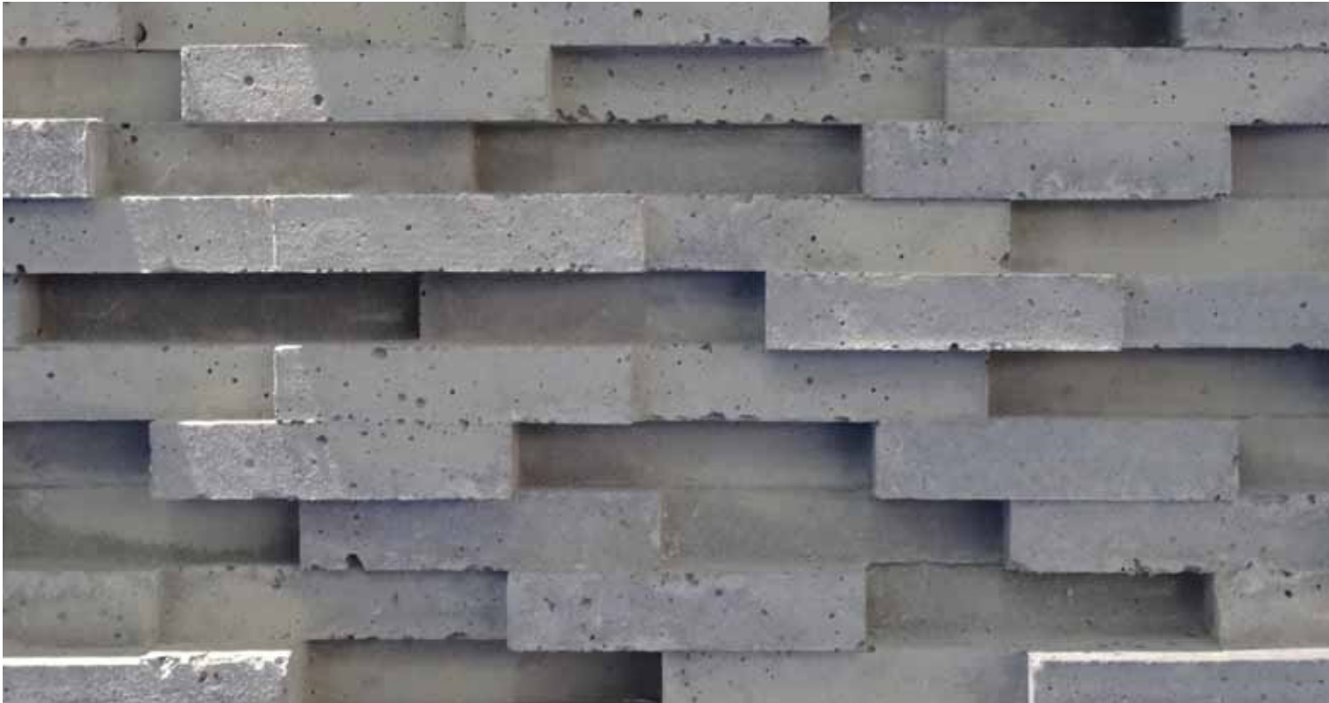
Ztotožnění rozpraskaného městského betonu s vrstvou křídových mořských usazenin je prorockým slovem antropocénu. Foto baunetwissen.de
