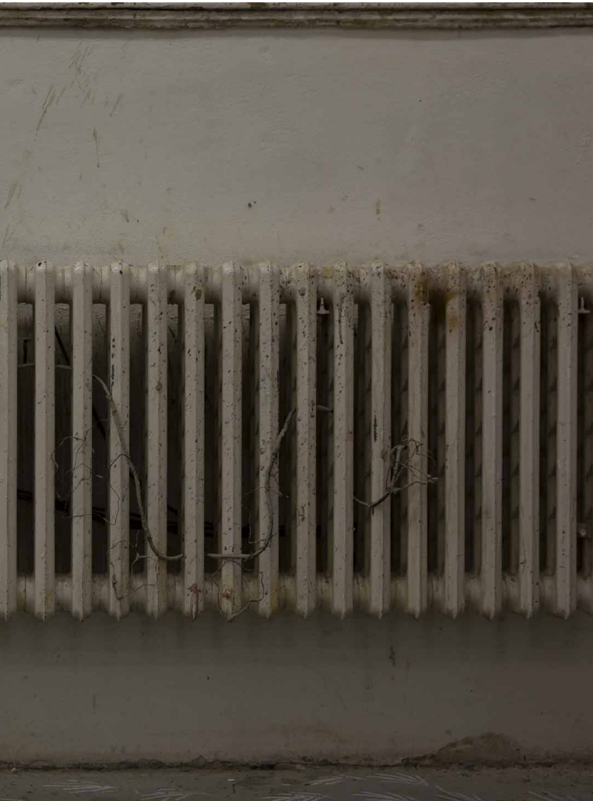
Hubert Švaříček: Zaniknout docela snadno, instalace (drát, cement), 2022. Foto Nikola Rácová
