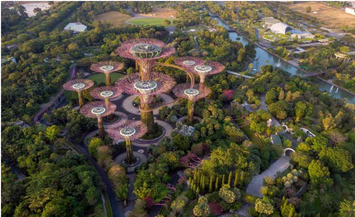
Chytrý městský park Gardens by the Bay v Singapuru je nejznámější příklad solarpunkové architektury. Tyto superstromy slouží jako skleníky, vyrábějí elektřinu ze sluneční energie a sbírají dešťovou vodu. Foto Sergio Sala
